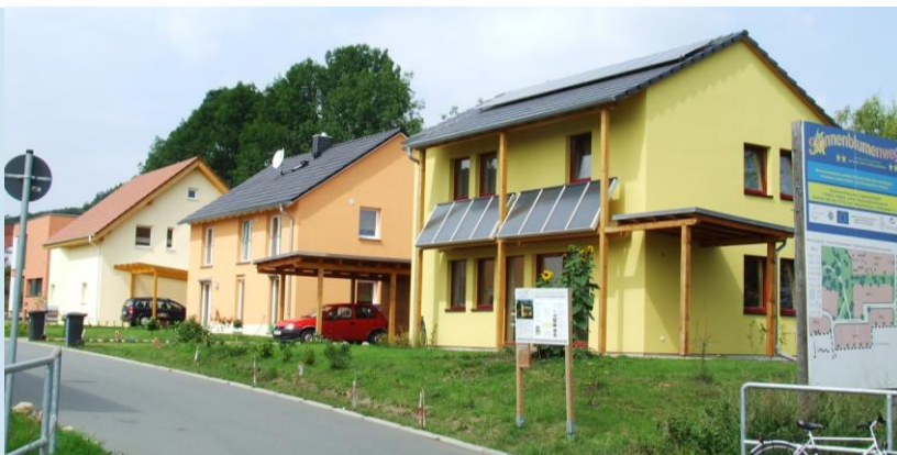
Solarhaussiedlung „In den Fichtlerswiesen“
